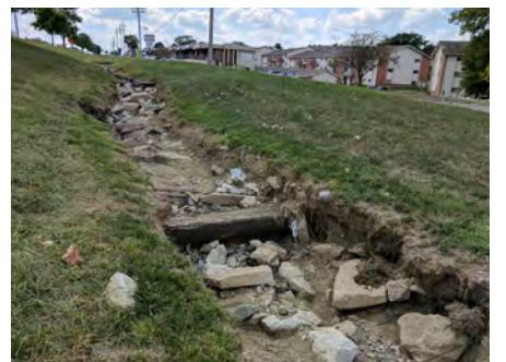
OPEN DRAINAGE CHANNEL WITH SEVERE EROSION
