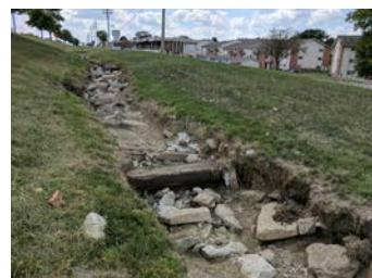
OPEN DRAINAGE CHANNEL WITH SEVERE EROSION
